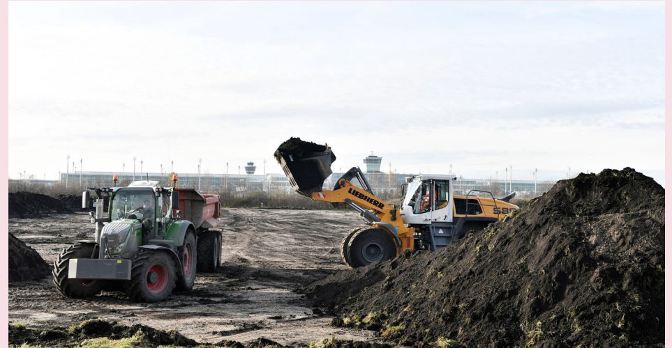
Nach großflächigen Erdmassenbewegungen
